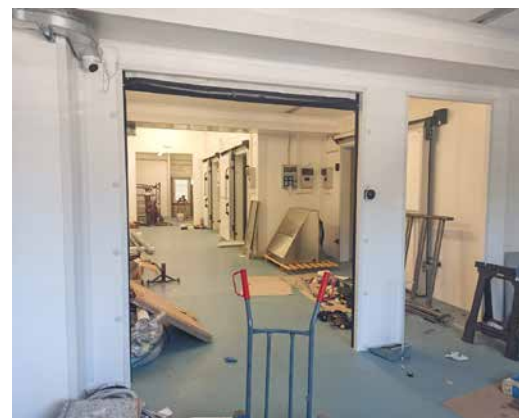
▲ Magazzino e impianto di lavorazione del pescato (progetto MIZAR)
